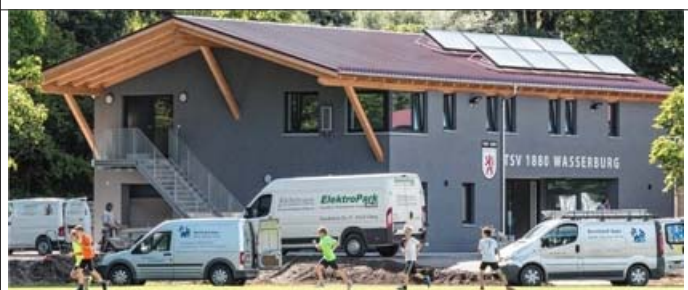
In nur neun Monaten zum neuen Sportheim: Auf der Baustelle haben auch viele Sportvereins-Mitglieder ehrenamtlich mit angepackt. FOTO CATER
